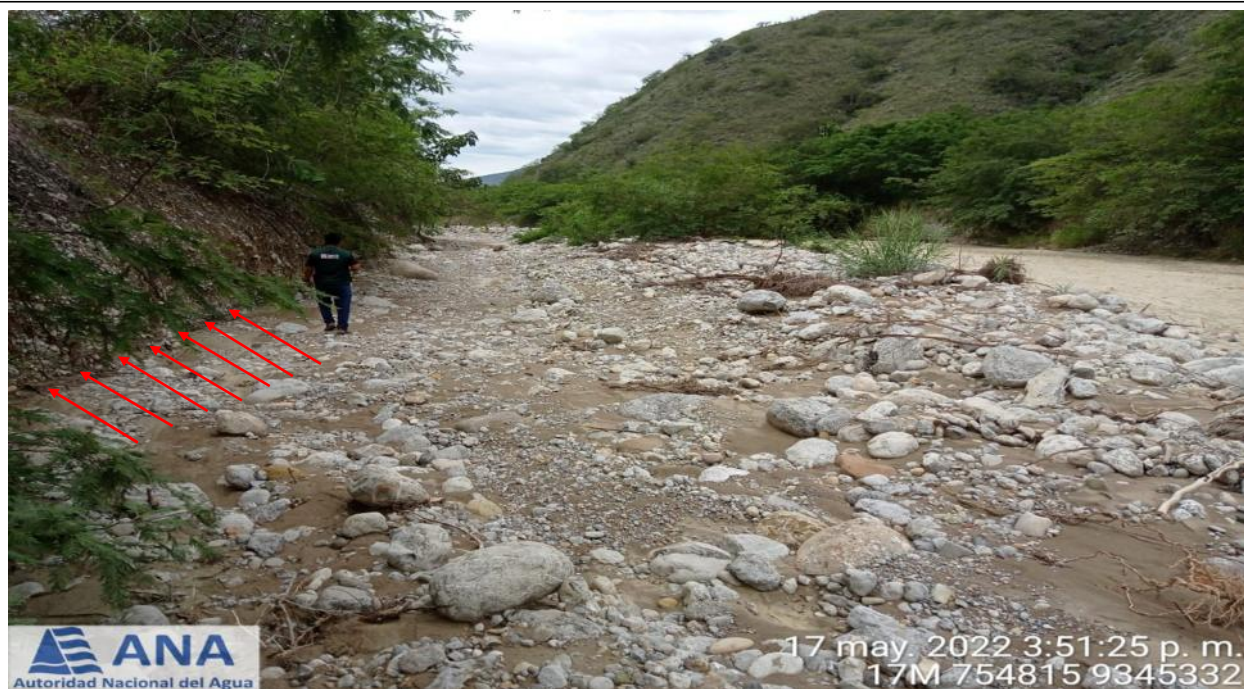
FOTOGRAFIA N°03: SOCAVACIÓN EN LAMARGEN IZQUIERDA DE LA QUEBRADA LA LIMA EN LA TEMPORADA DE MAXIMAS AVENIDAS.
