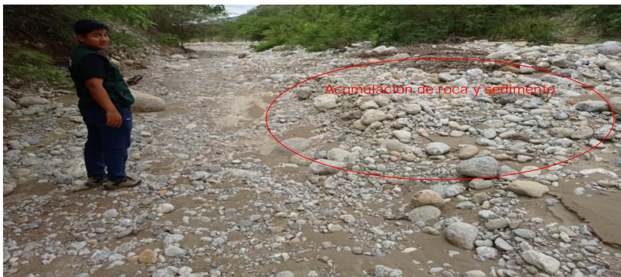
FOTOGRAFIA N°02: MATERIAL COLMATADO EN EL CAUCE DE LA QUEBRADA LA LIMA , CON UNA PROFUNDIDAD PROMEDIO DE 0.5 M.
